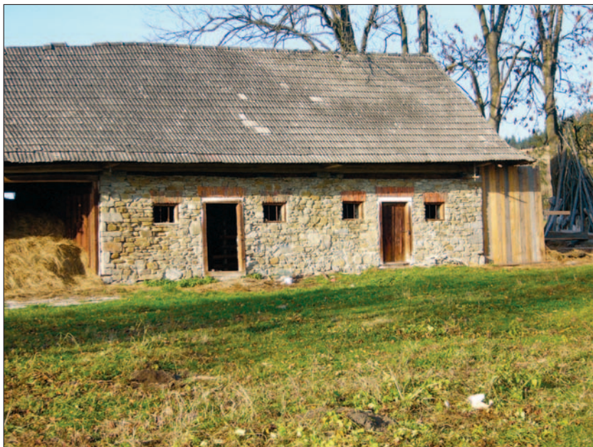
Fot. 5. Piaskowiec jako materiał budowlany, Zubrzyca Dolna 2008 r. (fot. K. Miraj)
