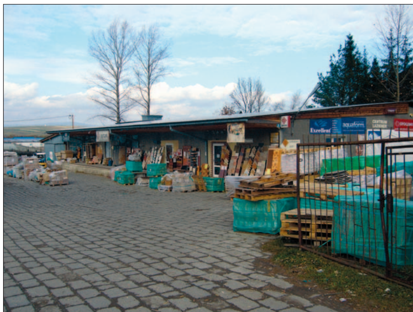
Fot. 15. Pogeesowska rozlewnia piwa wykorzystywana obecnie jako sklep i skład płytek ceramicznych, Jabłonka 2008 r. (fot. K. Miraj)
