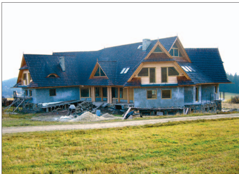
Fot. 30. Budowa pensjonatu „Orawski Dwór”, przykład zagospodarowania turystycznego w sąsiedztwie Babiogórskiego Parku Narodowego, Zubrzyca Górna 2007 r. (fot. K. Miraj)
