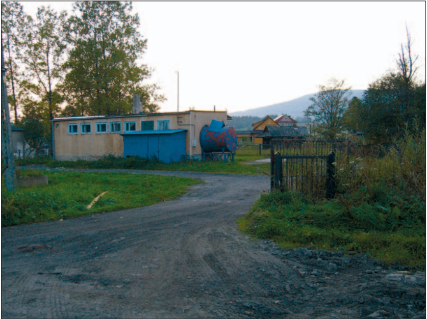
Fot. 25. Budynek dawnej zlewni mleka OSM Nowy Targ, Zubrzyca Górna 2007 r. (fot. K. Miraj)
