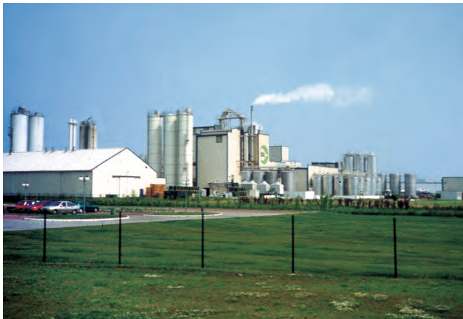
Fot. 3. Cargill w Bielanych Wrocławskich - korzystająca z lokalnego surowca rolnego wytwórnia syropu glukozowego wybudowana w podwrocławskim węźle drogowym w gminie Kobierzycze
