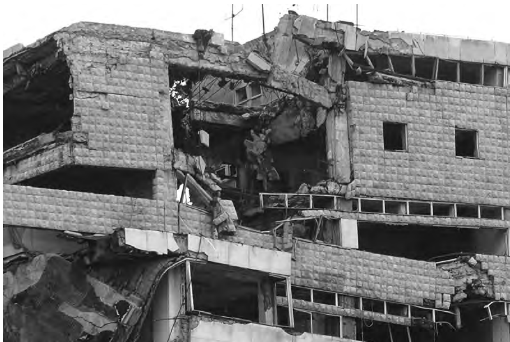
Fot. 21. Serbia. Centrum Belgradu – pozostałości po budynkach zbombardowanych w 1999 r.
