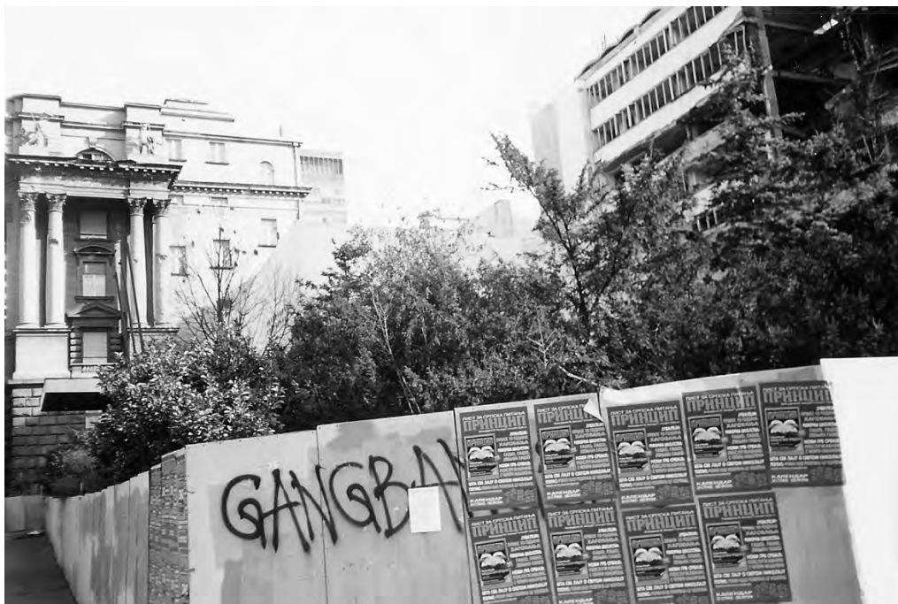
Fot. 20. Serbia. Centrum Belgradu – pozostałości po budynkach zbombardowanych w 1999 r.
