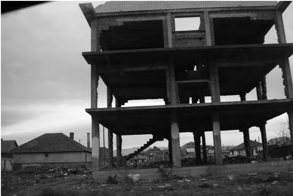
Fot. 17. Kosowo. Zdewastowane domy, należące do Serbów przed 1999 r.
