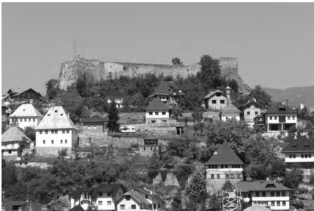
Fot. 5. Bośnia i Hercegowina. Jajce – obecnie miejscowość zamieszкана przez Muzułmanów i Chorwatów; tuż pod ruinami starej twierdzy widać domy zniszczone przez bombardowania podczas wojny w Bośni i Hercegowinie 1992–1995; gdzieś tam widać też na ścianach dziury po seriach karabinów maszynowych
