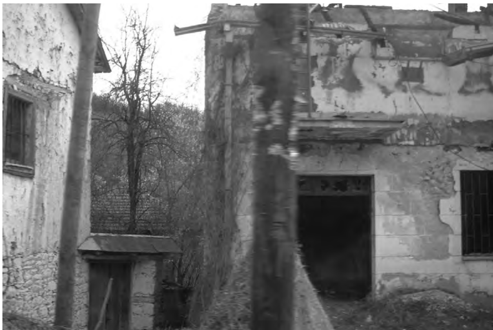
Fot. 16. Kosowo. Zdezastowane budynki, należące do Serbów przed 1999 r.
