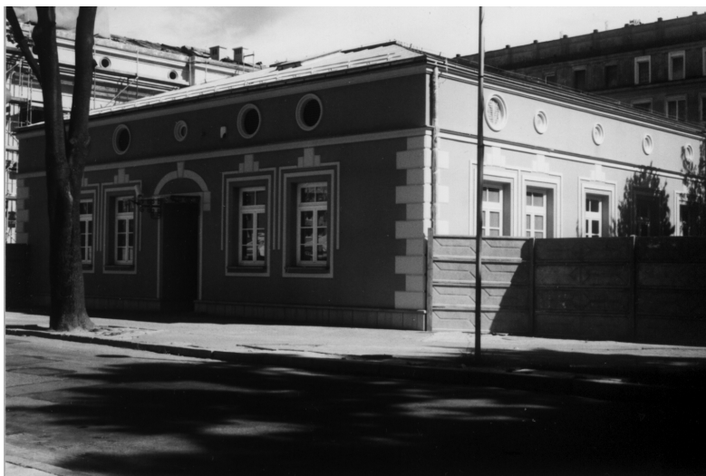
Budynek odwachu miejskiego w Częstochowie przy ul. Marii Panny (pawilon zachodni, istniejący do dziś). Wygląd współczesny
