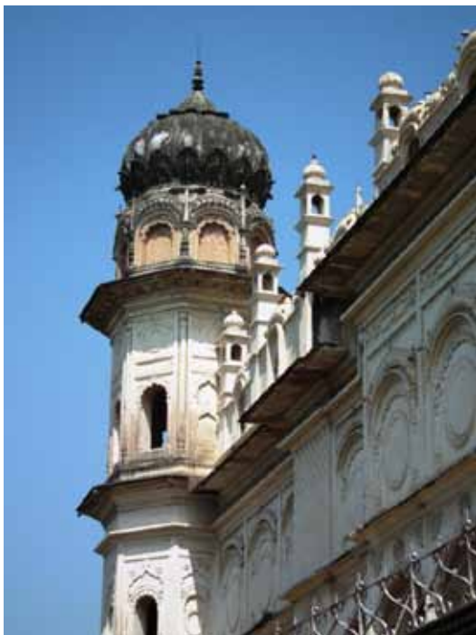
6. Bahū Begam ka Makbara , Fajzabad, widoczne dekoracje elewacji i dachu (fot. autorki).
