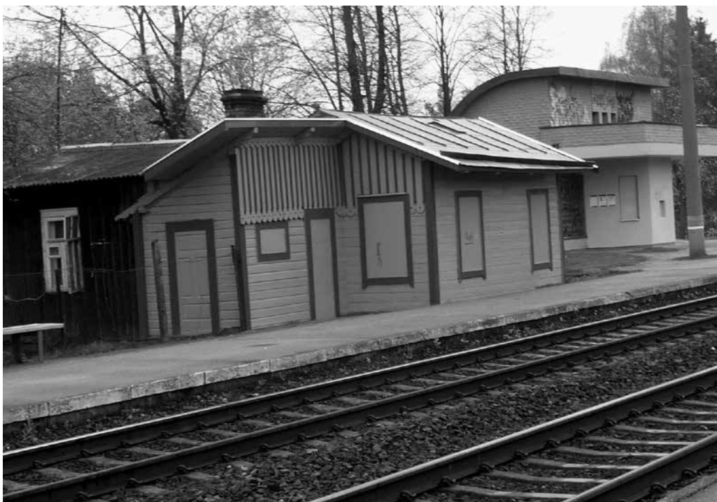
Stacja kolejowa w Kolonii Wileńskiej.
