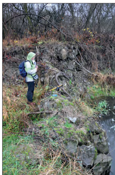
Fot. 3. Odcinki koryta z erozją wgłębną, widoczne zawieszenie i zniszczenie regulacji hydrotechnicznych; A – odc. 14, B, C – odc. 4
