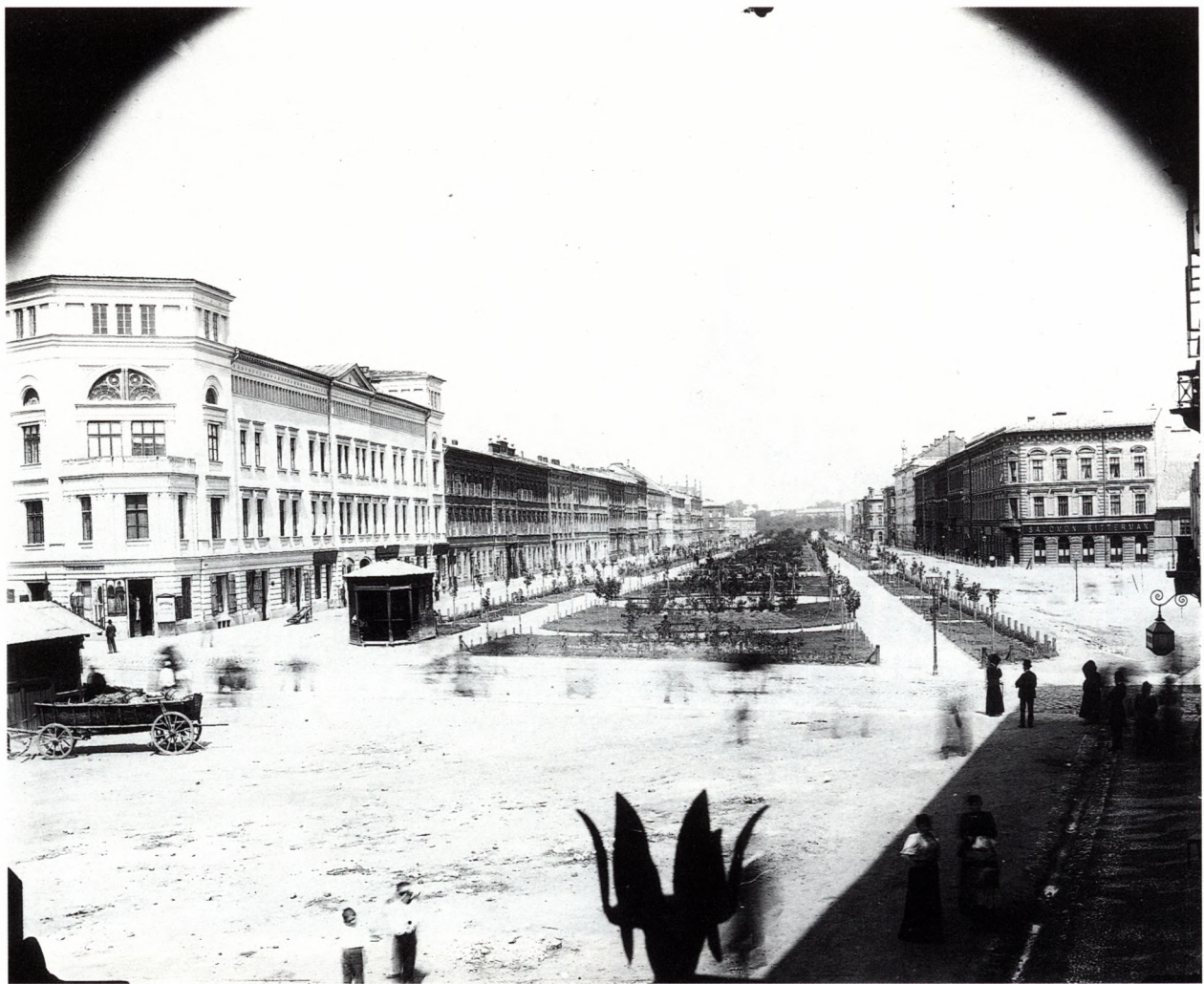
Abb. 6 Dietelstraße mit Grünanlagen, »Plenty«, an Stelle des alten Weichselbettes.
