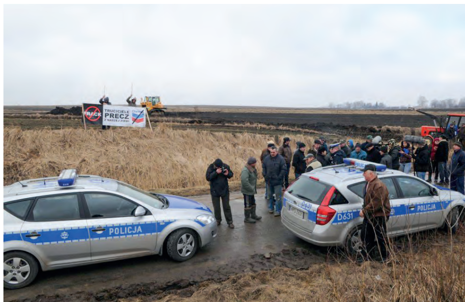
Zdjęcie 3. Blokada mieszkańców podczas próby rozpoczęcia prac ziemnych w Żurawlowie, w tle – pracujący spychacz, 13.03.2012, fot. Andrzej Bąk
