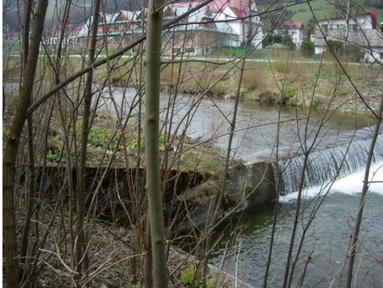
Fot. 7 Widok na wzmocnienia betonowe brzegu potoku Porębianki w badanym odcinku P2.
