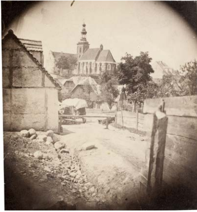
210. Gniezno, kościół św. Jana, pd. skrzydło d. klasztoru bożogrobców oraz zabudowa mieszkalna w dolinie rzeki Srawy. Fot. nieznan, nie później niż 1879
