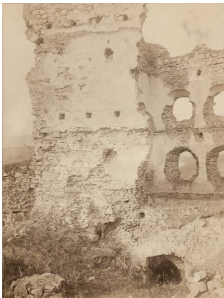
121. Czorsztyn, zamek, widok wieży od dziedzińca.
