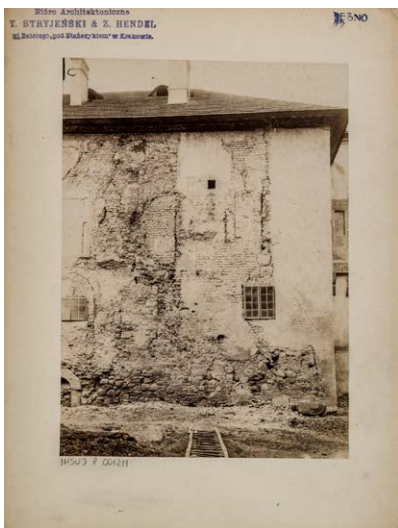
130. Dębno Brzeskie, zamek, fragment elewacji wsch. Fot. W. Demetrykiewicz, 1898 (?)
