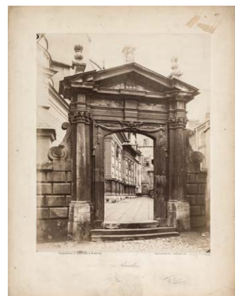
401. Kraków, katedra, bramka w murze.
