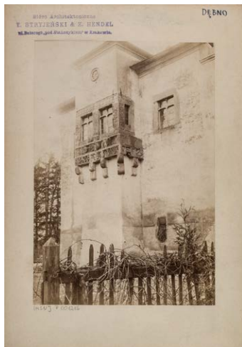
134. Dębno Brzeskie, zamek, wykusz w elewacji pn.
