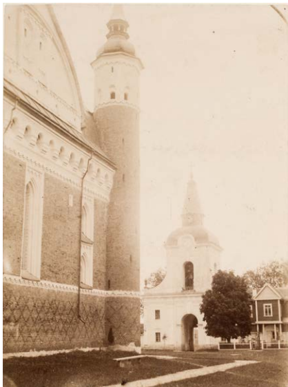
1413. Supraśl, cerkiew Zwiastowania, fragment elewacji bocznej. Fot. nieznanymi, nie później niż 1897 (?)
