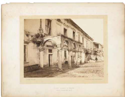
1668. Zamek, skrzydło pałacowe od strony dziedzińca IHSUJ A 000002/1
