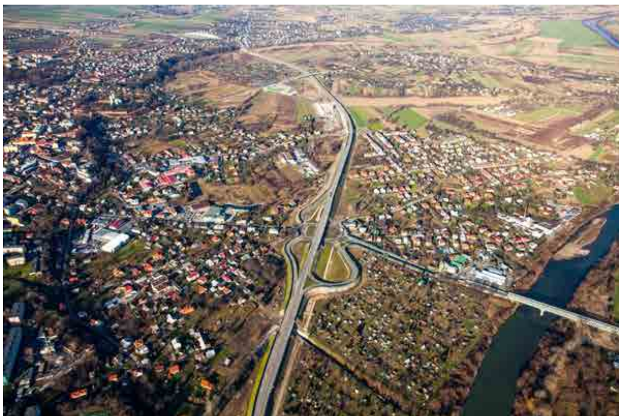
Fot. 17. Środkowy odcinek obwodnicy Jarosławia - z prawej strony most na Sanie, a z lewej - centrum miasta.
