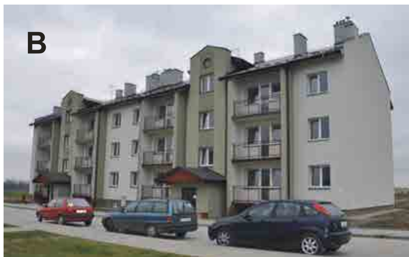
Fot. 19. Mieszkania socjalne przy ul. Wróblewskiego: A. budynek parterowy, B. blok.
