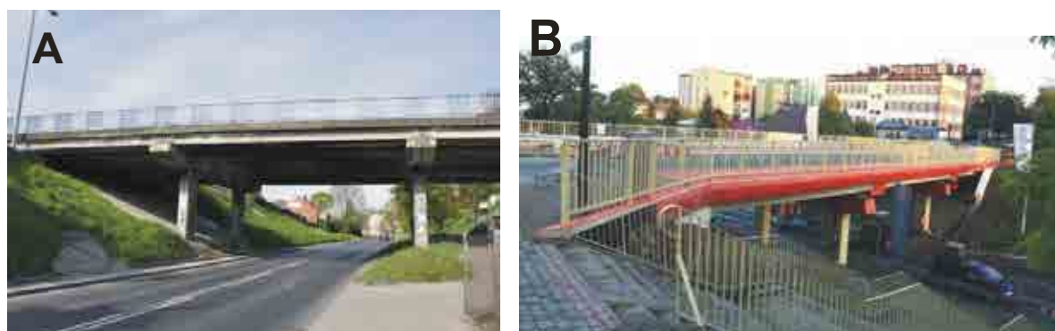
Fot. 20. Wiadukt drogowy przy ul. Przemyskiej: A. przed remontem, B. po remoncie.
