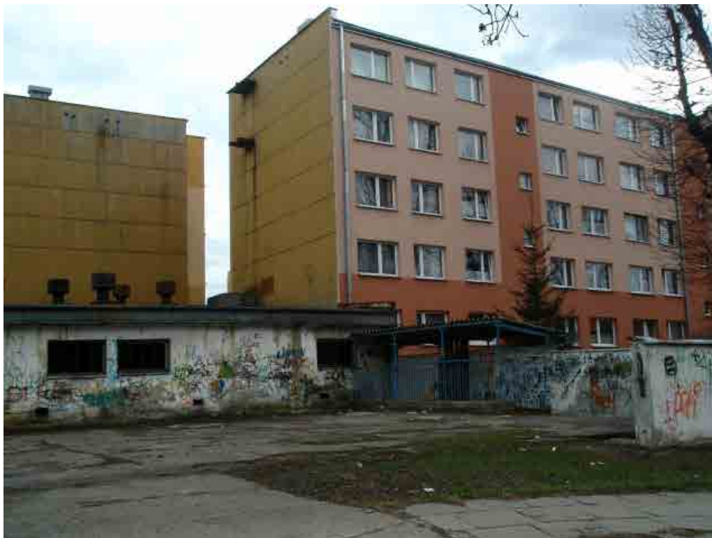
Fot. 22. Dawna kotłownia na os. Pułaskiego, przy bloku nr 1 (Fot. autorki).
