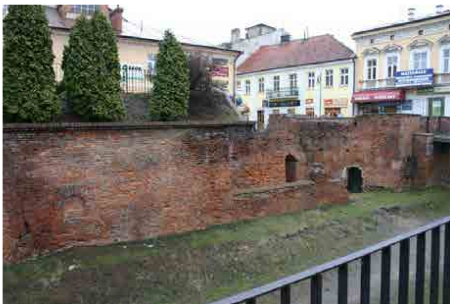
Fot. 16. Odsłonięty fragment murów obronnych i Bramy Krakowskiej przy ul. Grodzkiej (Fot. autorki).
