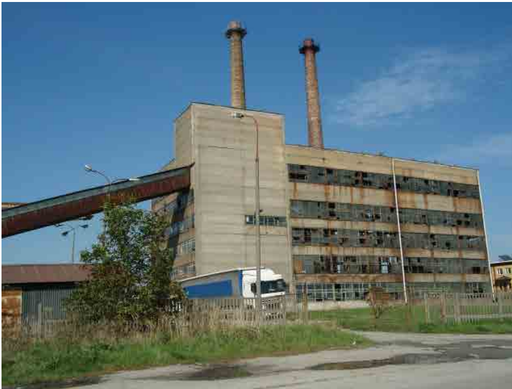
Fot. 21. Dawna ciepłownia, przy ul. Morawskiej (Fot. autorki).
