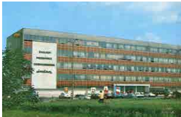
Fot. 15. Budynek dawnych ZPD "Jarlan".
