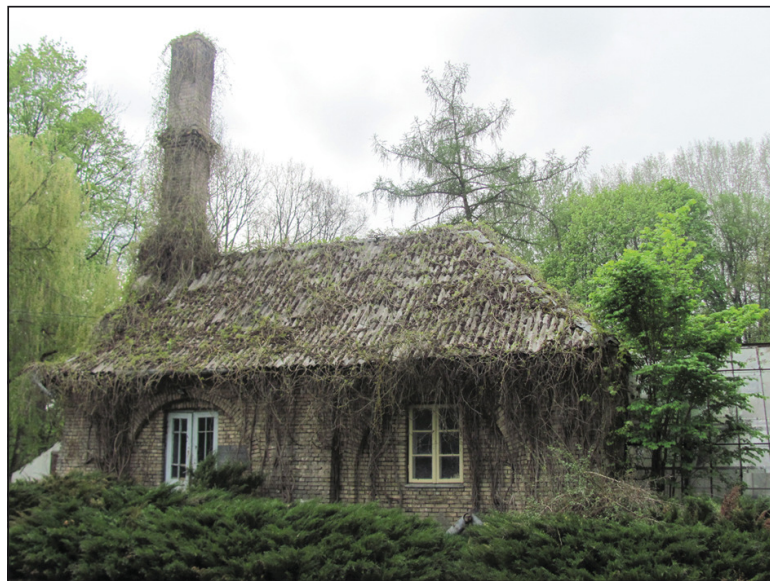
Ryc. 8. Budynek kotłowni przy dwóch szklarniach zbudowanych przez Uniwersytet Stefana Batorego w Wilnie – widok dzisiejszy (szklarnie są zrekonstruowane).
