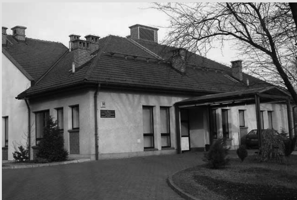
Budynek przy ul. Kopernika 50 - pracownia MR
