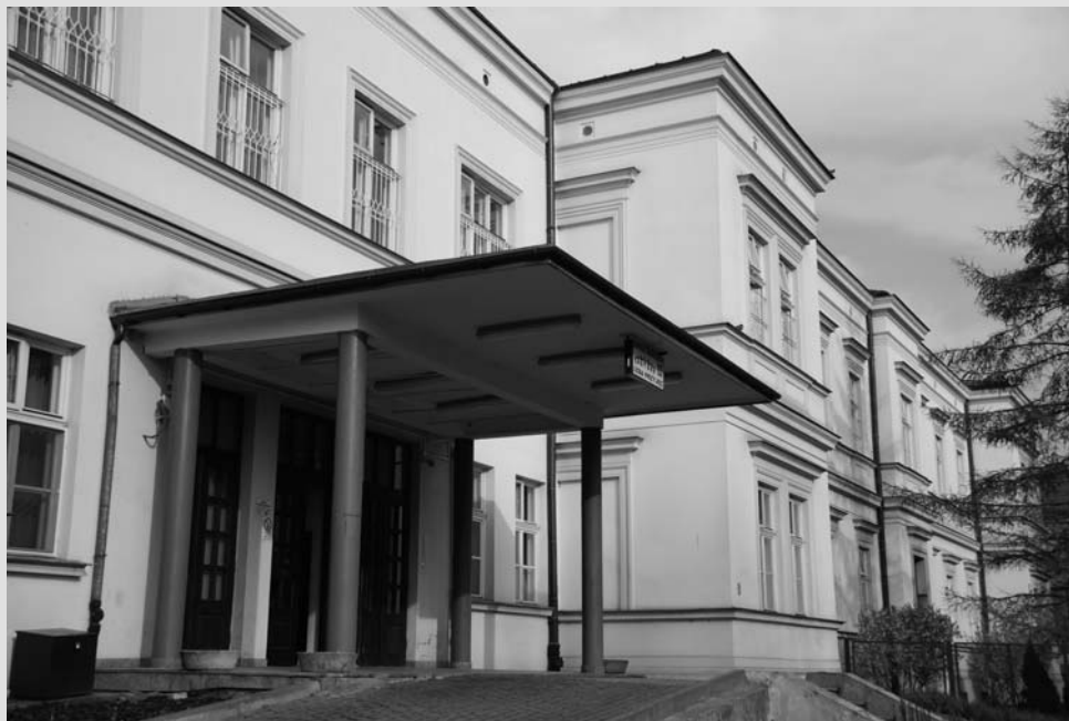
Budynek przy ul. Strzeleckiej 2
