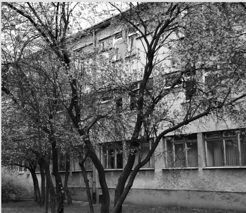
Budynek przy ul. Śniadeckich 10
