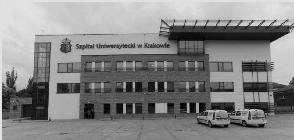
Budynek przy ul. Kopernika 50 - CUMRiK
